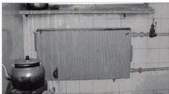
安装在花家地北里的钢串片散热器
